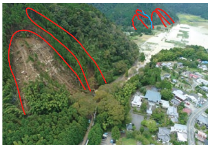
▲伊東市池地区被災状況(令和元年)
