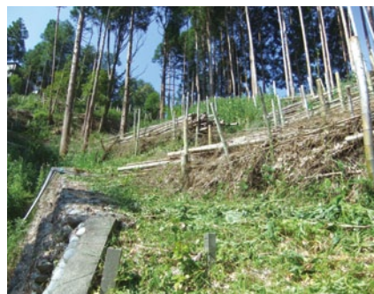
▲島田市伊太 (R3 整備後)
