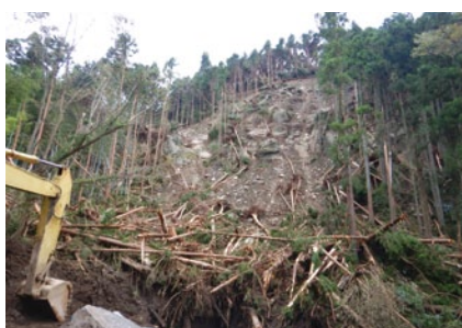
▲崩壊直後の状況(令和元年)
