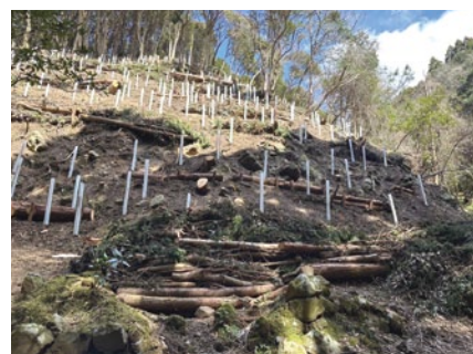
▲施工後の状況
