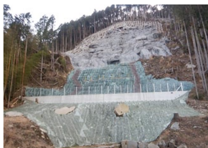
▲施工完了時の状況(令和3年)
