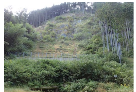
▲復旧した現在の状況(令和6年)
