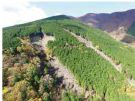
▲山腹崩壊の発生状況
