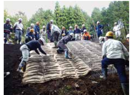
▲協議会による緑化資材の設置(小崩壊地の復旧)
